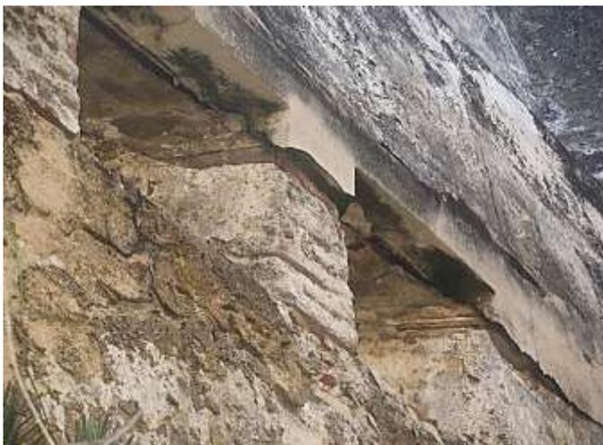
**Fig. 12** Agrietamiento de los dinteles sobre las aspilleras por corrosión y expansión de las barras de hierro dentro de la estructura de los dinteles.
