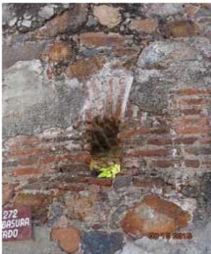
**Fig. 5** Detalle de las aspilleras.
