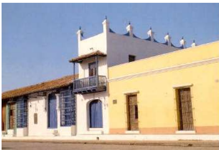
Fig. 5 La entrada directa a la casa por la sala, y el zaguán de servicios son la base de la fachada
