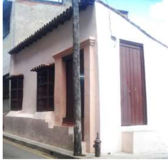
Fig. 6 Alero en la Fachada rehabilitada Fuente: Foto tomada por: Sandra Peña y Yenny Gómez
