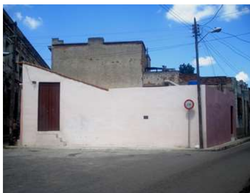
Fig. 1 Fachada lateral hacia la plazuela Fuente: Foto tomada por: Sandra Peña y Yenny Gómez
