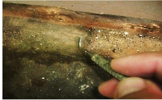
Fig. 15 Limpieza mecánica, retiro de tierra acumulada.
