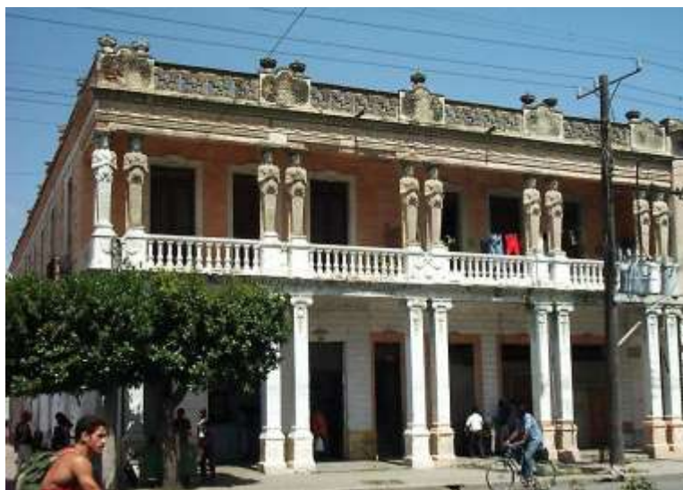
Fig. 2 Edificio en Avenida de los Mártires # 58 Fuente: Archivo digital del CECONS
