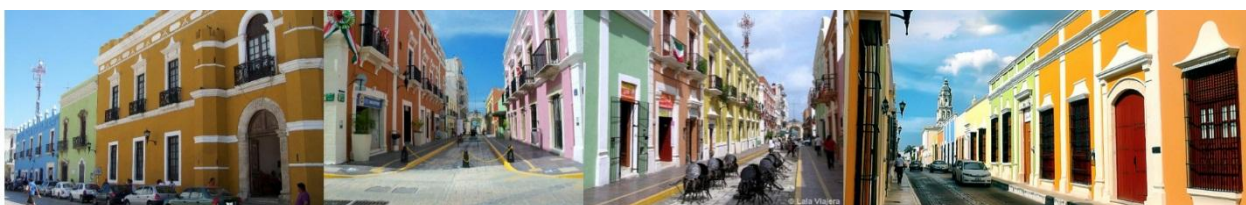
Fig. 2: Restauración y mantenimiento de la imagen urbana
