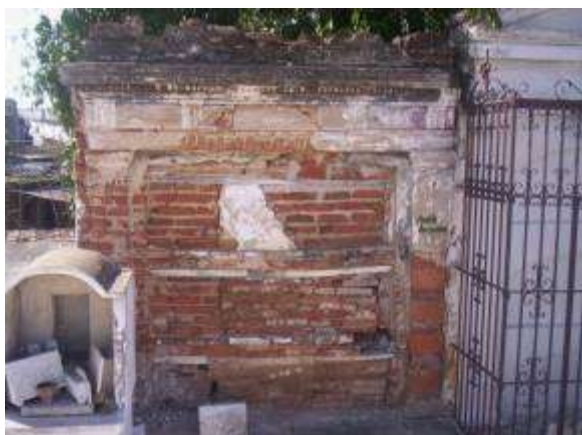
Figs. 7 y 8 Panteón adosado a pared limitrofe del Primer Tramo, por calle San Clemente, estado ruinoso, fallo estructural, pérdida de los elementos decorativos y del revestimiento, fallo de los entrepisos. Detalle del cartel que indica su estado Fuente: Archivo de la autora
