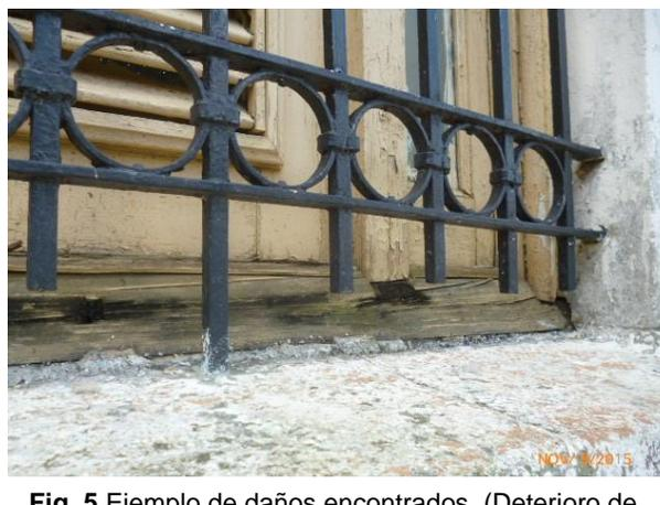
**Fig. 5** Ejemplo de daños encontrados. (Deterioro de la madera).
