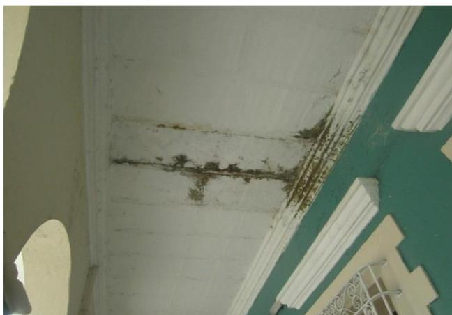
**Fig. 2** Ejemplo de daños encontrados. (Humedad).
