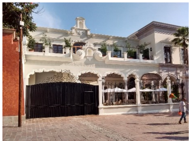
Fig. 7 Eclecticismo apreciable en una intervención Fuente: Foto del autor
