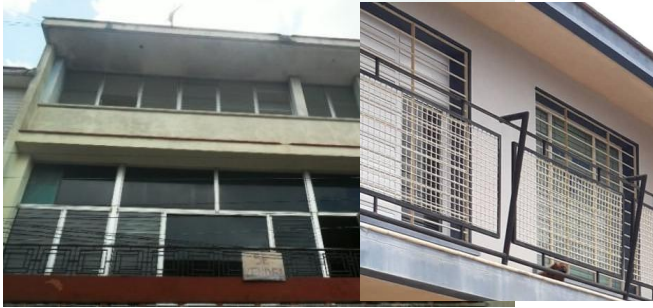
Fig. 3 Cambios operados en los vanos para un mejor logro de la relación interior-externo. Edificio en Popular No. 126 (1958) y vivienda en Avenida de los Mártires No.359 (1958)
