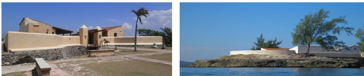
Fig. 1 Batería Fernando VII; vista frontal y lateral derecha Fuente: Tomada por el autor (2019)
