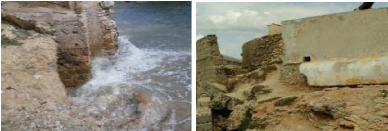
Fig. 4 Acción del oleaje sobre la línea costera y las edificaciones
