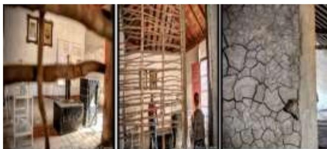
**Fig. 11** Entretejido de cujes en la conformación de los muros de embarrado
