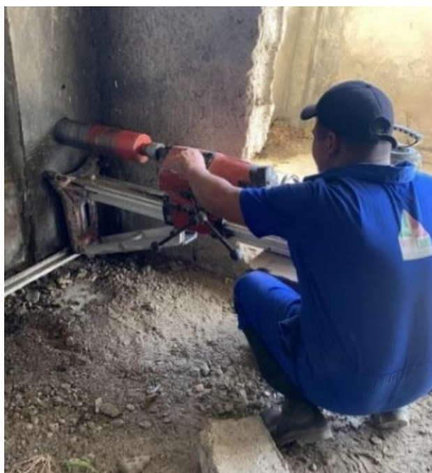
Fig. 4 Extracción de los testigos de hormigón Fuente: Fotos tomadas por el autor. Abril 24 del 2020
