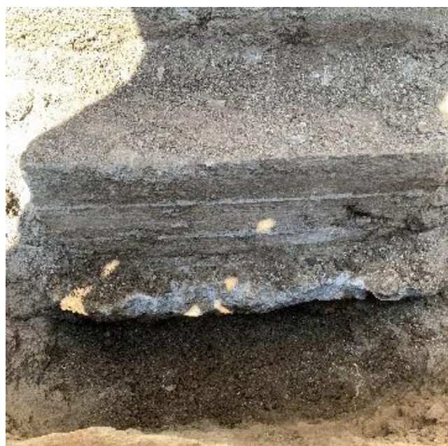
Fig. 9 Calicata realizada Fuente: Foto tomada por los autores
